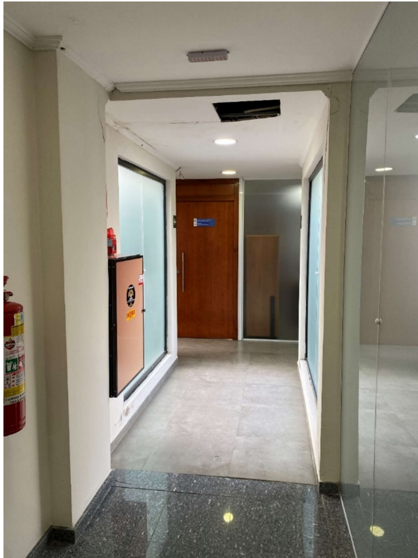
Foto 48 – Vista da passarela de acesso ao bloco II.
