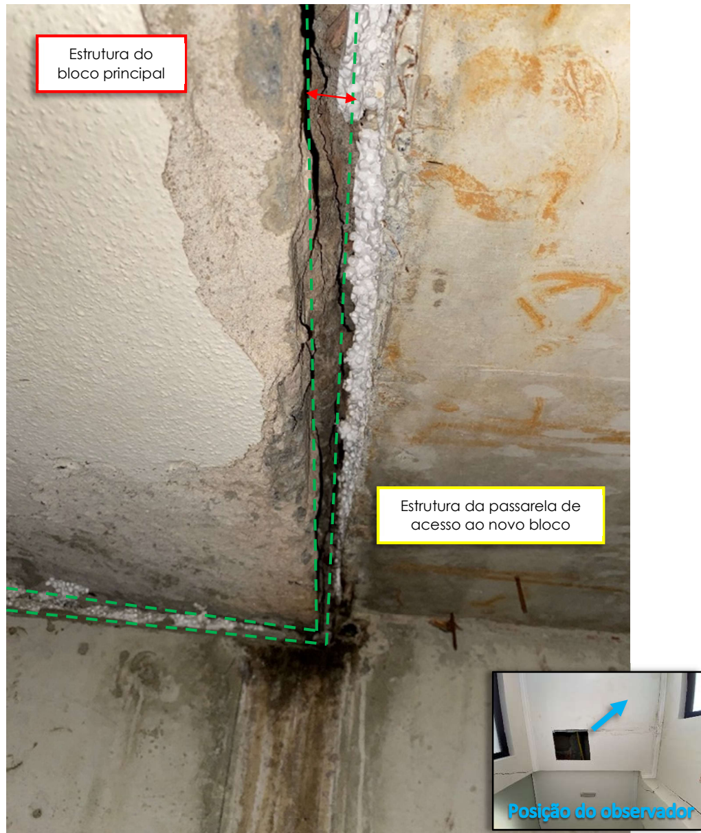
Foto 59 – Vista do encontro entre a laje de cobertura da passarela e o beiral do bloco principal, apresentando o aumento do afastamento entre as estruturas do bloco principal e da passarela de acesso ao bloco II.
