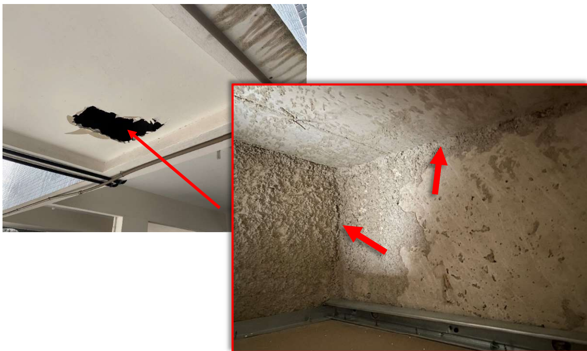
Foto 30 – Vista da abertura nº 3, no sentido oposto ao encontro com o bloco principal. Foi constatado que a estrutura da passarela se encontra ancorada na estrutura do bloco de ampliação, não apresentando trincas e nem fissuras.
