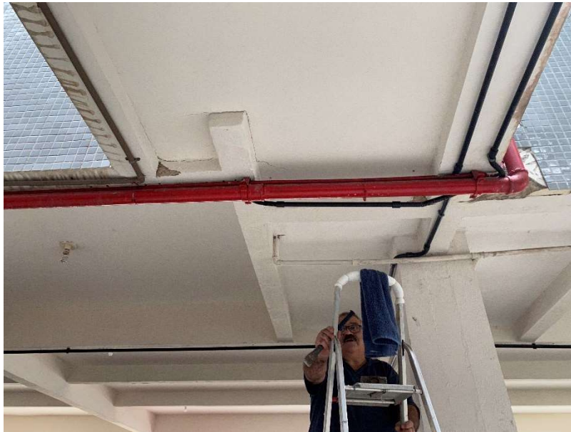
Foto 20 – Vista do forro de gesso antes da execução dos nichos de inspeção para a análise interna da estrutura.
